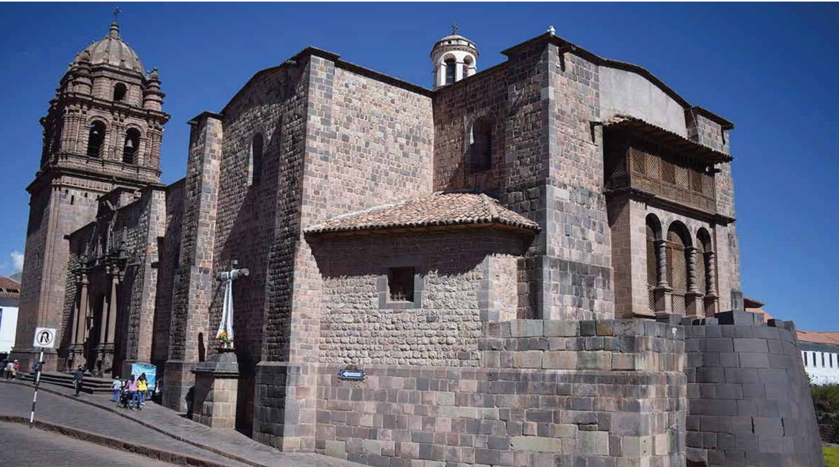
Sobre los cimientos del Coricancha Inca los españoles construyeron el Convento de Santo Domingo.
